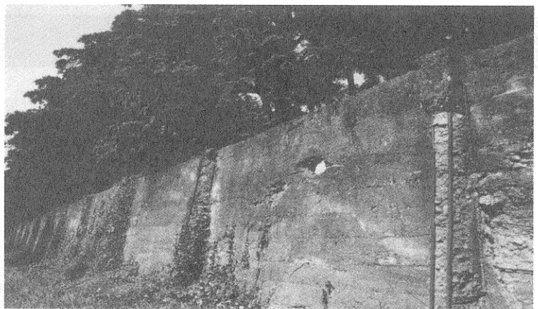
菊池恵楓園のコンクリート堀 （堀の穴は、入所者が堀の外を見るためにあけたといわれています。）
