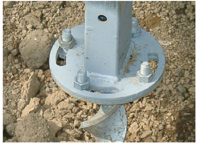
写真5 スパイラル基礎
