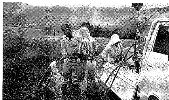
写真-5 ホース流下方式暗渠目詰り除去作業
