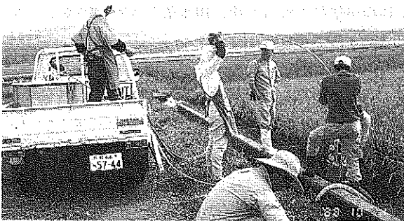
写真-4 上流押し込み方式暗渠目詰まり除去作業
