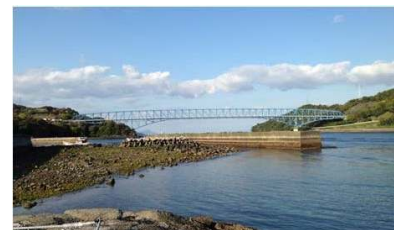
j. 黒の瀬大橋 (1974年) / トラス橋
