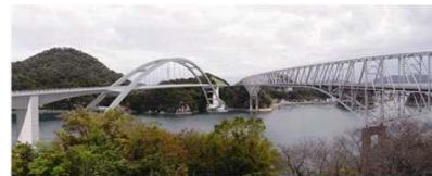
新天門橋 / アーチ橋 (完成イメージ) 竣工2016年度未予定。 天門橋の北側約100mの位置に架橋されて、 完成すれば全国 2位のアーチ支間長の橋となる。
