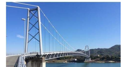
k. 東大維橋 (1975年) / 吊橋
