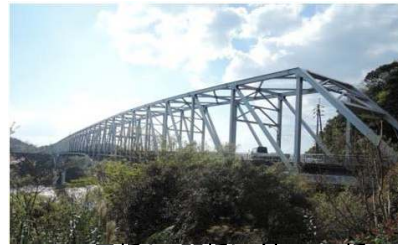
a. 1号橋(天門橋) / トラス橋
