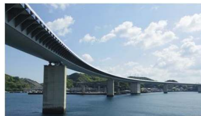
i. 牛深ハイヤ大橋 (1997年) / 鋼箱桁橋
