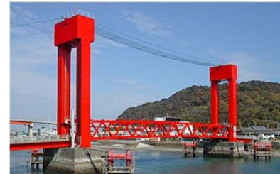
g. 本渡瀬戸昇開橋 (1978年) / トラス橋
