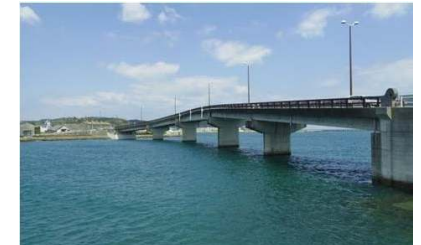
h. 平成橋 / P C 単純T 桁橋
