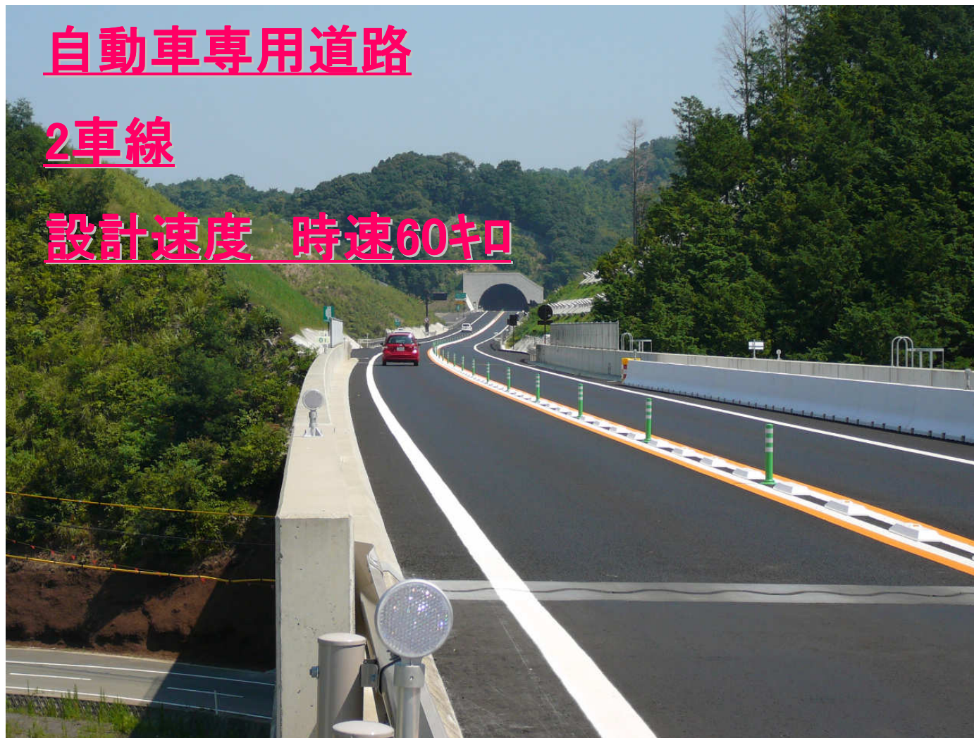
松島有明道路 【供用中:状況写真】
