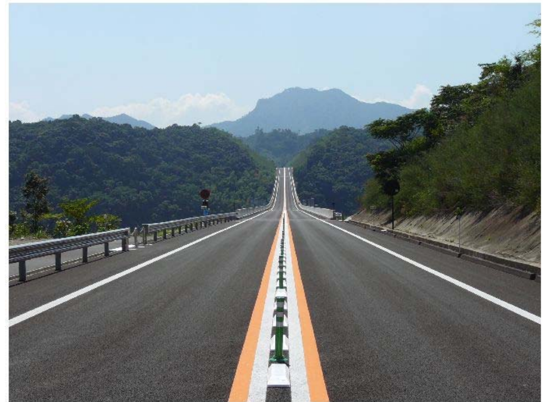
写真-4.1 松島有明道路の幅員構成(現状)
