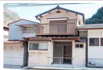
空き家を改修した移住者用住宅
