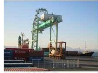
ガントリークレーン
