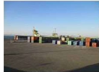
八代外港コンテナターミナル
