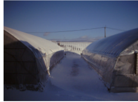
写真2 (平成17年12月22日撮影) 右側のハウスが空気二重膜ハウス。 対照ハウス(左側)に比べて、 積雪がほとんどなく、朝から日光が ハウスの中にはいっている。
