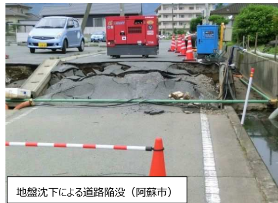
図 1-18 下水道管路の被災状況
