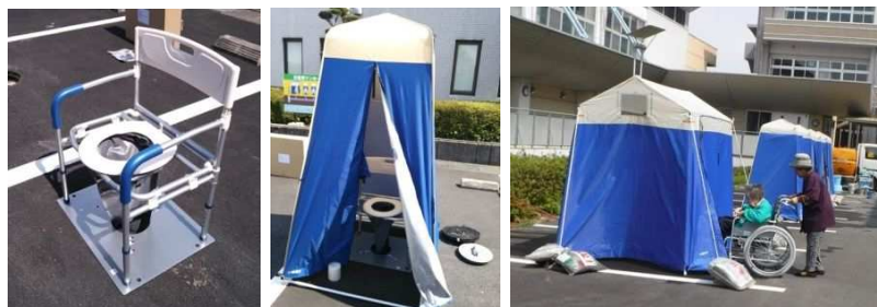
図 5-7 マンホールトイレ設置状況
