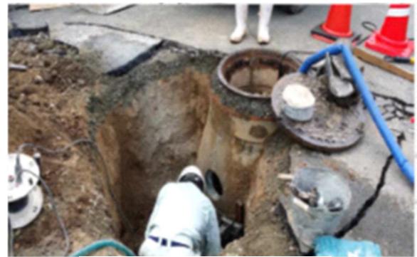
応急復旧(バイパス管)
