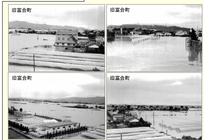
写真 1-2-1 浸水状況写真
