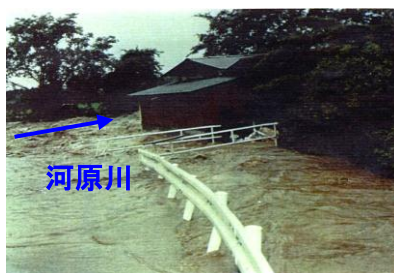
平成13年7月洪水による支川河原川第四藤田橋右岸側の被災状況
