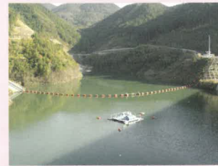
流木止め設備(網場)及び水質保全設備(曝気循環装置)
