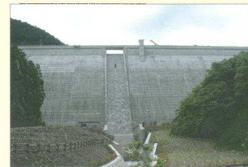
試験湛水 サーチャージ水位到達 (平成16年5月17日)
