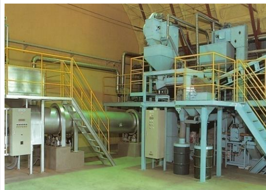
蛍光灯処理工場
