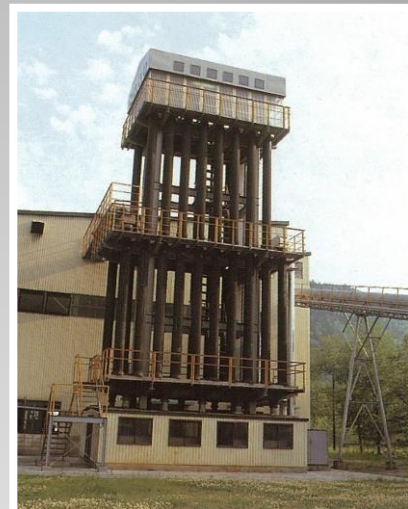
コンデンサータワー
