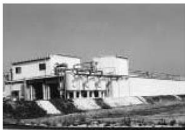
▲排水処理施設
