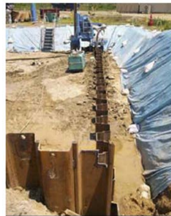
図8-20 遮水壁（鋼矢板）の打設状況
