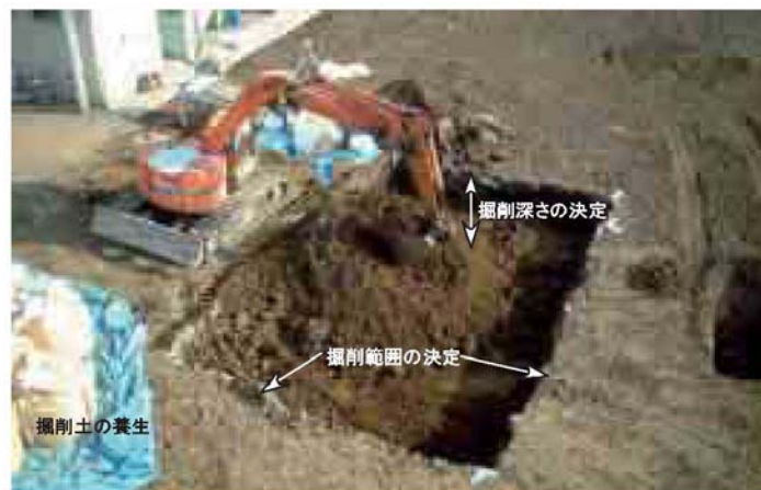
図 8-14 掘削除去の概況写真
