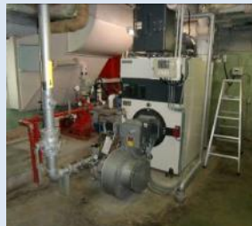
空気比を計算し調整
