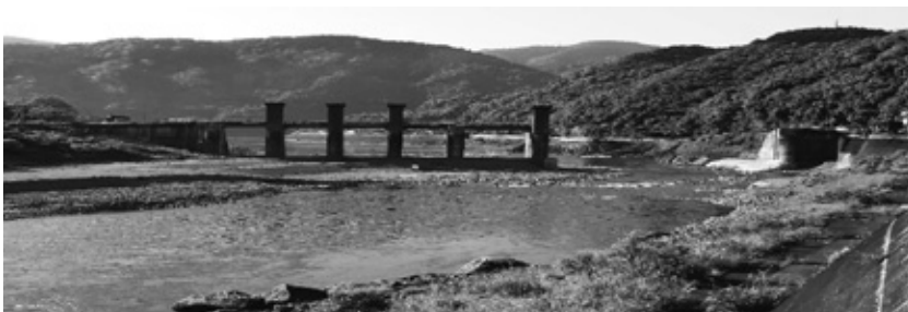
荒瀬ダム撤去状況（H27年5月時点）
