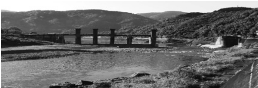
荒瀬ダム撤去状況（H27年5月時点）
