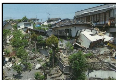
写真1 建物及び宅地擁壁の倒壊
