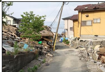
写真2 狭隘道路沿いの建物倒壊
