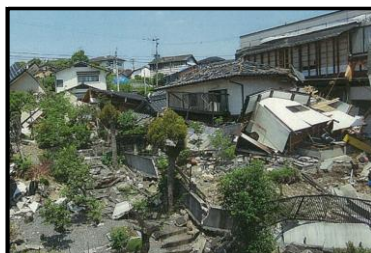
写真1 建物及び宅地擁壁の倒壊
