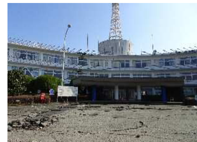
震災遺構として保存する東海大学阿蘇校舎1号館建物
