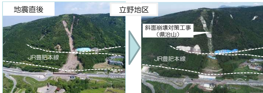
JR豊肥本線沿線斜面崩壊対策工事の着実な推進
