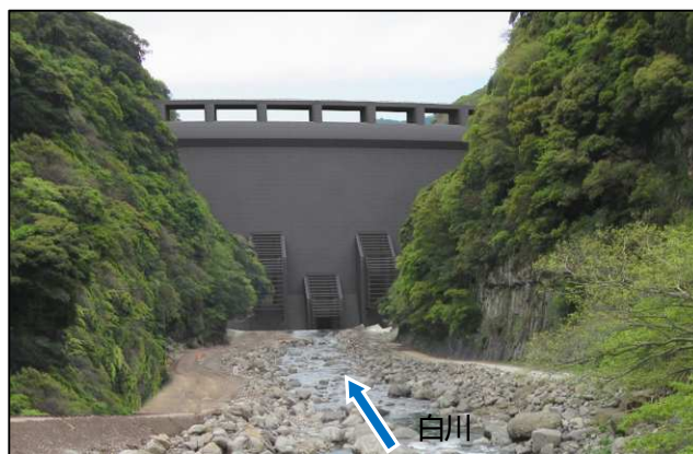
上流側からダムを望む
