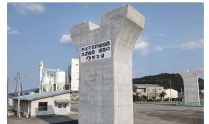
熊本天草幹線道路 P9 橋脚の完成 (H31.3)
