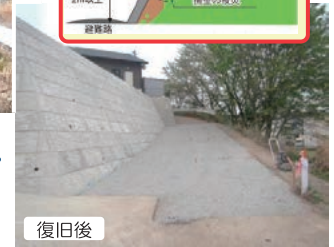
被災宅地の復旧
