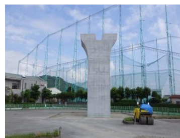
熊本天草幹線道路 P10 橋脚の完成 (H30.5)
