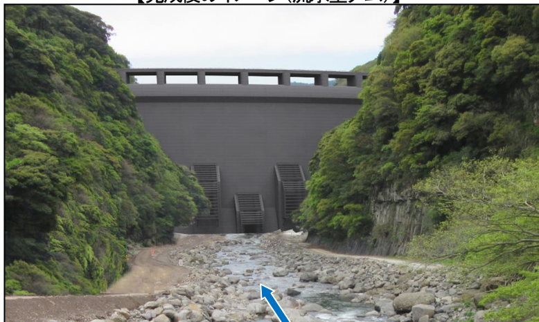
上流側からダムを望む
