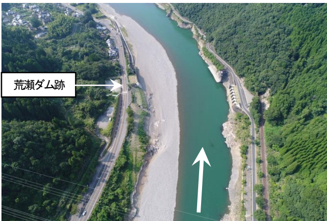
撤去完了後(H30.7)
