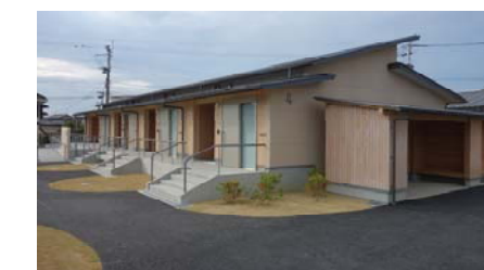
宇土市営境目団地災害公営住宅 (H30年9月完成)
