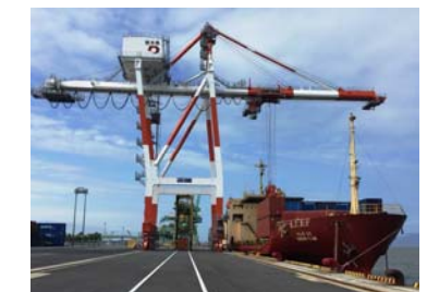
八代港大型ガントリークレーン
