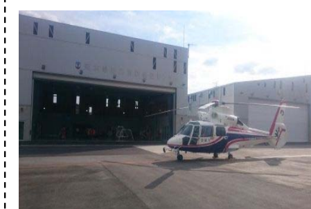
総合防災航空センター
