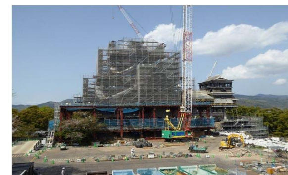
熊本城 天守閣の復旧状況
