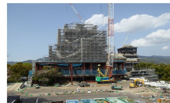
熊本城 天守閣の復旧状況
