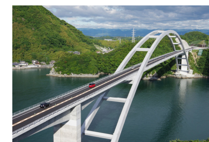
大矢野バイパス(天城橋)の開通(H30年5月)
