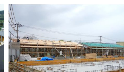
宇土市菅境目団地災害公営住宅 (H30年11月完成予定)
