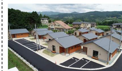
西原村河原地区災害公営住宅 (H30年6月完成)
