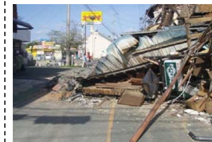
地震直後の県道熊本高森線の状況
