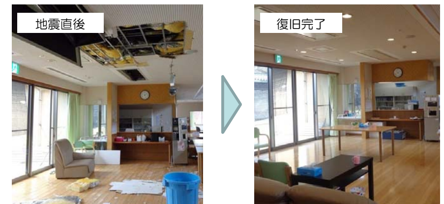
被災社会福祉施設の復旧状況
