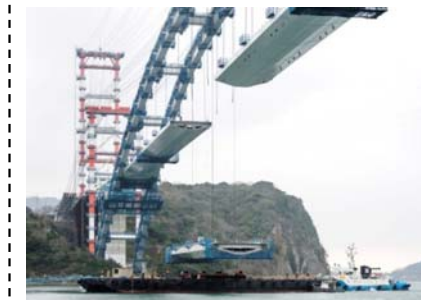
【熊本天草幹線道路】(仮称)新天門橋の架設状況
