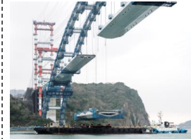
【熊本天草幹線道路】(仮称)新天門橋の架設状況
