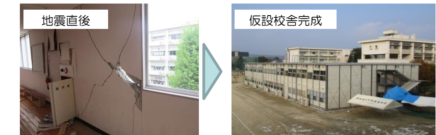
県立高校(熊本高校)の復旧状況
