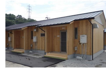
県産木材、県産畳を使用した応急仮設住宅
