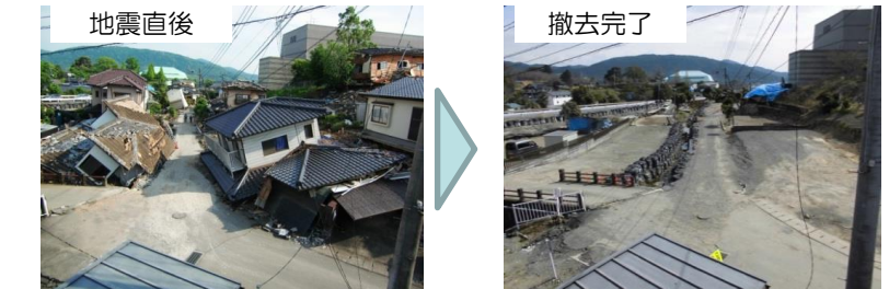
損壊家屋等の解体・撤去状況
