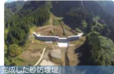
災害関連緊急砂防事業により完成した砂防堰堤
