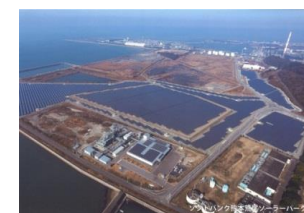
メガソーラーをはじめ、新エネルギーの導入が加速化
