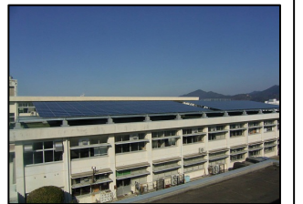
八代工業高校の太陽光発電システム
