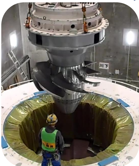
水車吊込み作業
