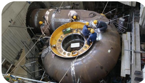
ケーシング取付作業
