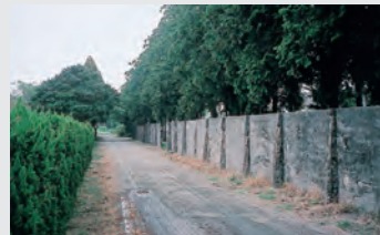
隔離の壁。2005（平成17）年10月に撤去された。
