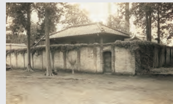
かつての監禁室。建設当時は外壁に囲まれていた。
