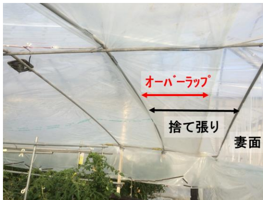
図26 捨て張り部分のオーバーラップ
