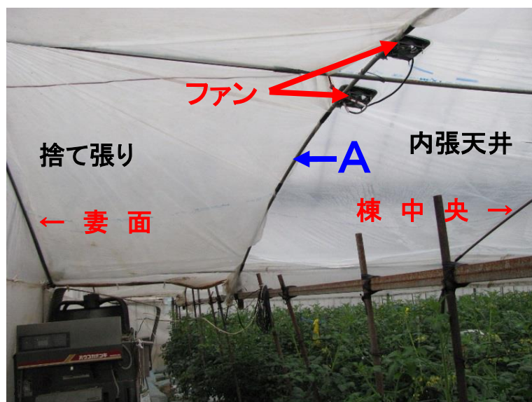
図14 ファンの取り付け状況
