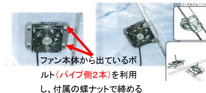
図16 ファン本体の取り付け手順(写真:「TS ツインエアファン」説明書より)
