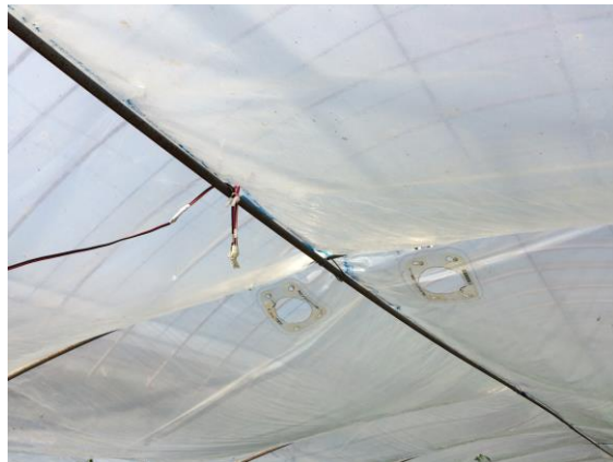
図28 内張からファンを撤去した状態
