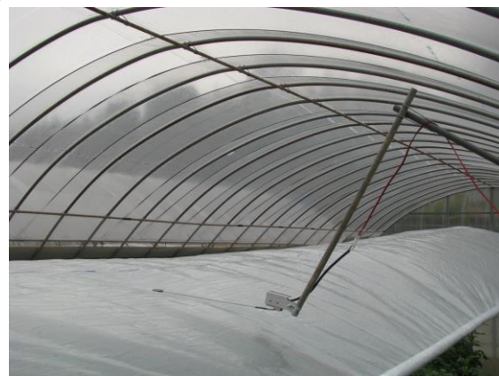
図19 膨らみセンサーの設置状況 (熊本県宇城市不知火町)
