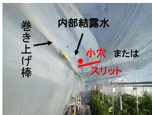
図24 内部結露水排水対策
