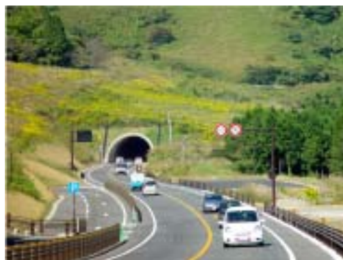
【景観に配慮したガードレール】
