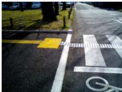
【横断歩道に設置した視覚障害者誘導用ブロック】
