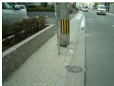
【歩道空間で支障となっている例】
