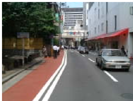
【路肩のカラー舗装化】
