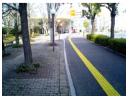
【民有地(左側)と歩道の一体化】
