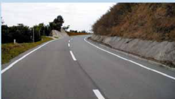
のり尻部のモルタル吹付（視距の確保・維持管理の軽減）
