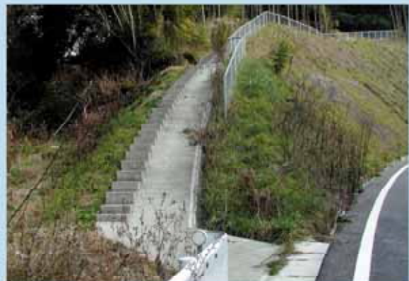
階段とスロープを取り入れた農道進入路
