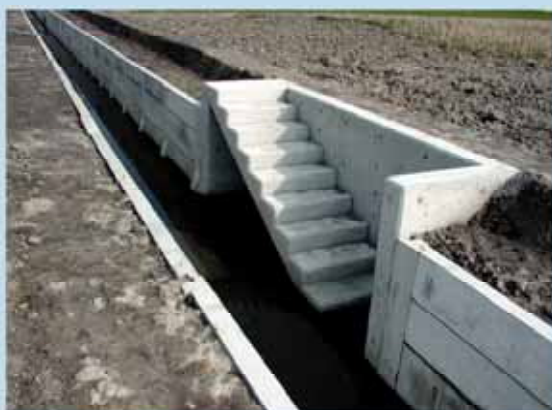
排水路の維持管理階段の設置
