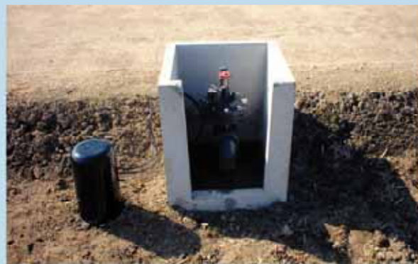
用水管理作業の自動化（左側はフロート）
