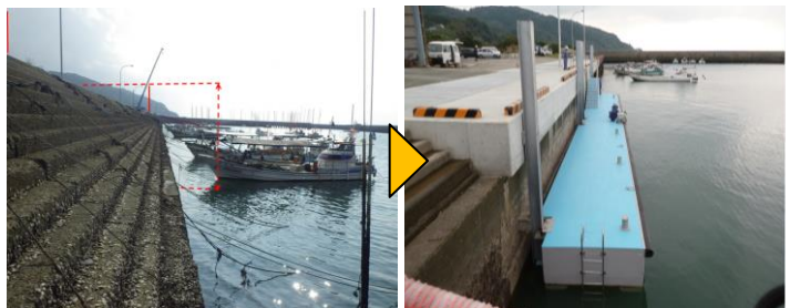
浮体式係船岸の整備（赤瀬漁港）
