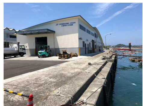
主要岸壁の耐震化（二江漁港）
