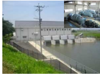
排水機場の更新
