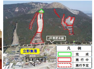
南阿蘇村立野地区の復旧状況
