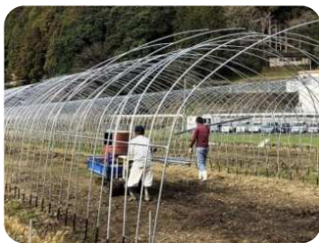
ハウス設置状況(自力施工)
