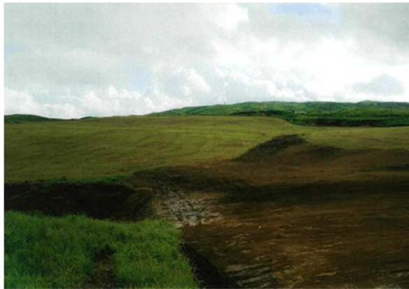
地割れを復旧した草地
