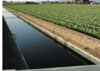
排水路の更新
