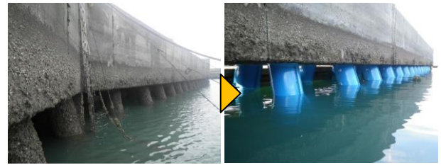
防波堤の補修（赤瀬漁港）
