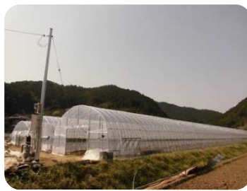
簡易ハウス設置
