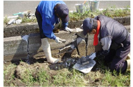
用水路補修状況
