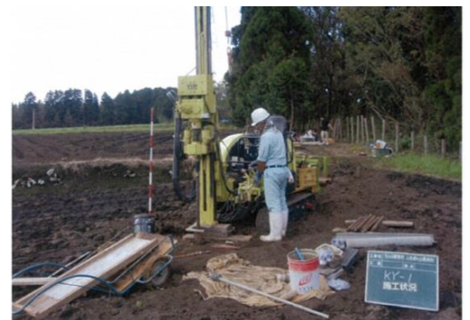
硝酸性窒素の地下への浸透状況調査分析 (熊本大学)
