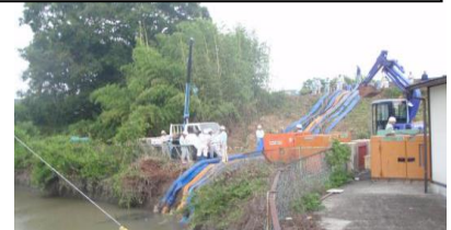
排水機場機能停止時の代替ポンプによる緊急対応 (宇城市)
