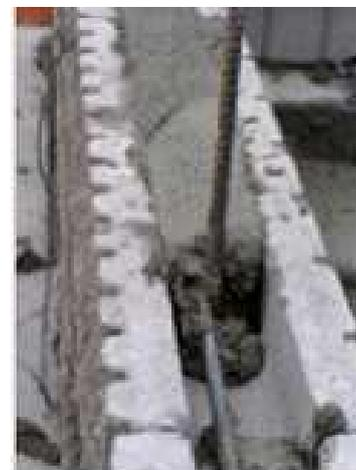
写真7 横筋用ブロックのモルタル充填
