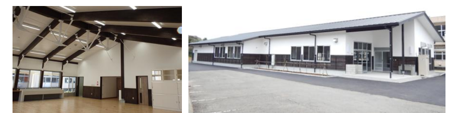
[県立岱志高等学校 工芸実習棟]
