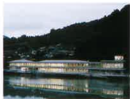
■荒瀬ダムボートハウス (八代郡坂本村)
