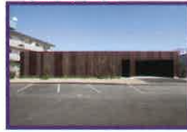
◆K-house in 近見 ①:熊本市 ②:古閑靖浩 ③:西山英夫建築環境研究所 ④:株式会社東陵建設
