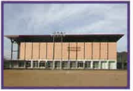
◆美里町立中央小学校体育館 ①:下益城郡美里町 ②:美里町 ③:有限会社SDA建築設計事務所 ④:株式会社高橋建設
