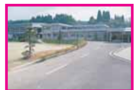
◆34 美里町福祉保健センター 「湯の香苑」 ①: 下益城郡美里町 ②: 美里町(旧中央町) ③: 有限会社SDA建築設計事務所 ④: 株式会社岩永組、他
