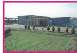
◆ 38 霧の倉庫 ①: 球磨郡多良木町 ②: 有限会社岡部麗香園 ③: 設計組織・RAM ④: 光進建設株式会社
