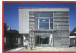
◆B'-studio ①: 熊本市 ②: 戸次和弘 ③: 一級建築士事務所ヒマラヤ ④: 株式会社九州建設
