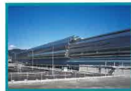
◆ 45 九州新幹線 新水俣駅 ①: 水俣市 ②: 鉄道・運輸機構九州新幹線建設局 ③: 株式会社西部交通建築事務所十渡辺誠・アーキテクトオフィス ④: 奥村・白石・光進特定建設工事共同企業体
