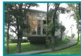
◆ 46 S.W.H ①: 阿蘇郡南阿蘇村 ②: 下村初幸 ③: 有限会社ロクス ④: 株式会社橋本建設十有限会社サユール電気設備
