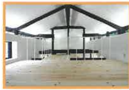
◆barn renovation ①: 菊池郡菊陽町 ②: 赤峰洋次 ③: 坂本達哉建築設計事務所 ④: 有限会社ウエダホーム
