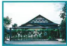
◆ 47 宮田の家 ①: 熊本市 ②: 三原 紀 ③: 有限会社U.L設計室 ④: 中村建築工房
