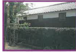
◆ 58 八代の町屋 ①: 八代市 ②: 坂井和子 ③: ばん設計小村事務所 ④: 有限会社楠元建設
