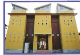
◆ 59 3 Towers ①: 合志市 ②: 上田敏雄、上田民子 ③: 菊池建築工房 ④: 有限会社高木ハウジング
