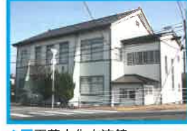
◆天草文化交流館 ①: 天草市 ②: 天草市 ③: 田中設計事務所 ④: 有限会社鶴田建設
