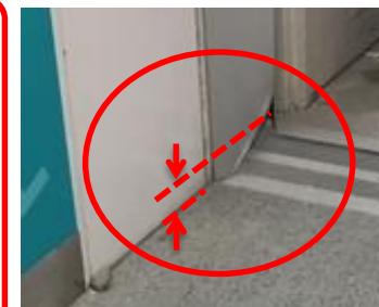
増築部取り合い躯体破損 段差発生 (10cm程度ずれ)
