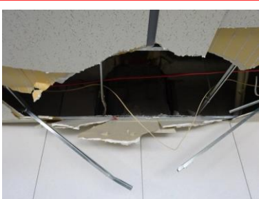
増築部取り合いコンクリート躯体落下
