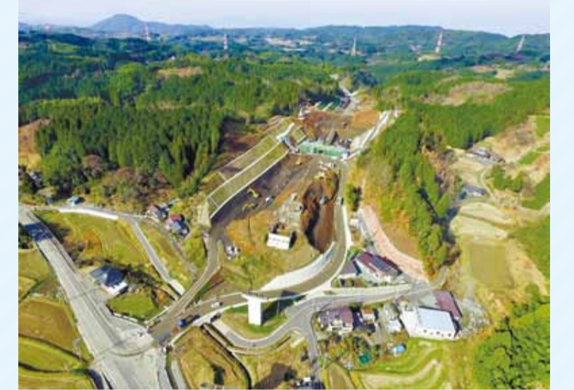
平成30年度の開通を予定している九州中央自動車道の小池高山IC(御船町)～北中島IC(仮称・山都町)間
