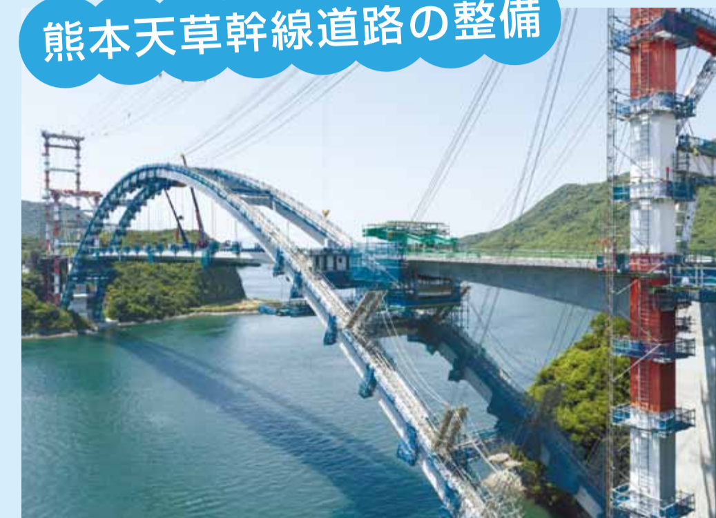
工事が進む新天門橋(仮称、橋長463m、6月撮影)
